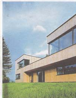
Der Ausblick auf den Mondsee war für die Gestaltung des Mehrgenerationenhauses in St. Lorenz zentral: Im Obergeschoß können beide Familien die Aussicht genießen, ohne sich gegenseitig dabei zu stören. Ein Gemeinschaftsraum wurde zwischen die beiden Wohneinheiten geschoben. Dieser fungiert als verbindendes Element zwischen den Häusern, sorgt aber zugleich für den notwendigen Abstand
